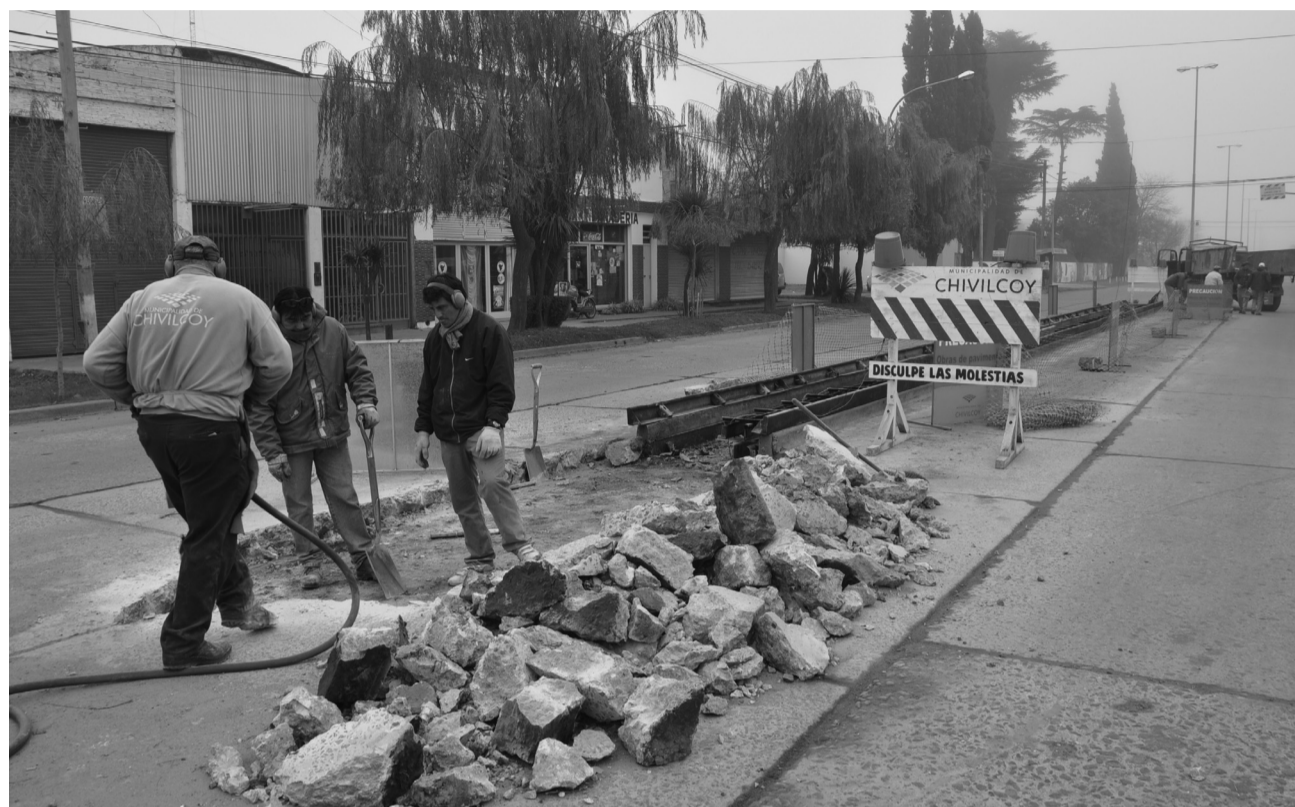
Construcción de bulevar en Avenida de Tomaso
