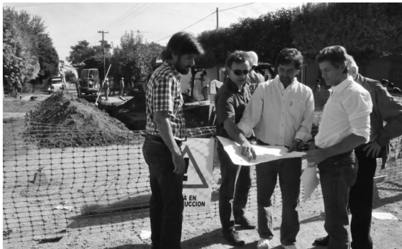
Ampliación de la Red Cloacal.
